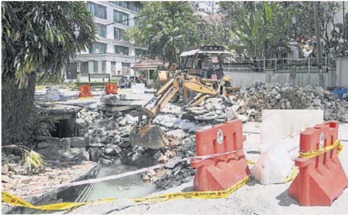
宇丹花园某公寓外围塌陷道路正进行维修。
